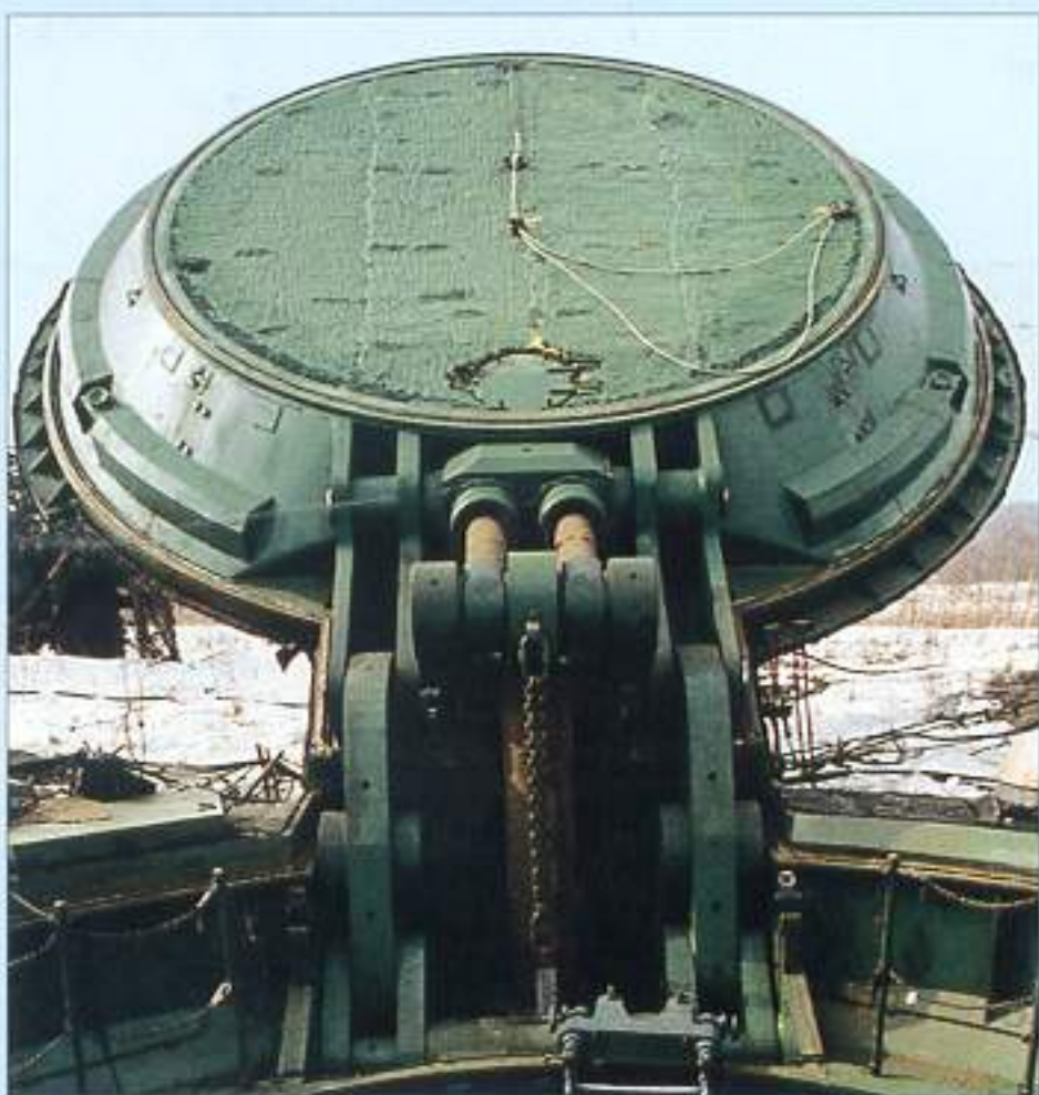
Типовая конструкция защитного устройства подъемно-поворотного типа Typical hinged protective device
