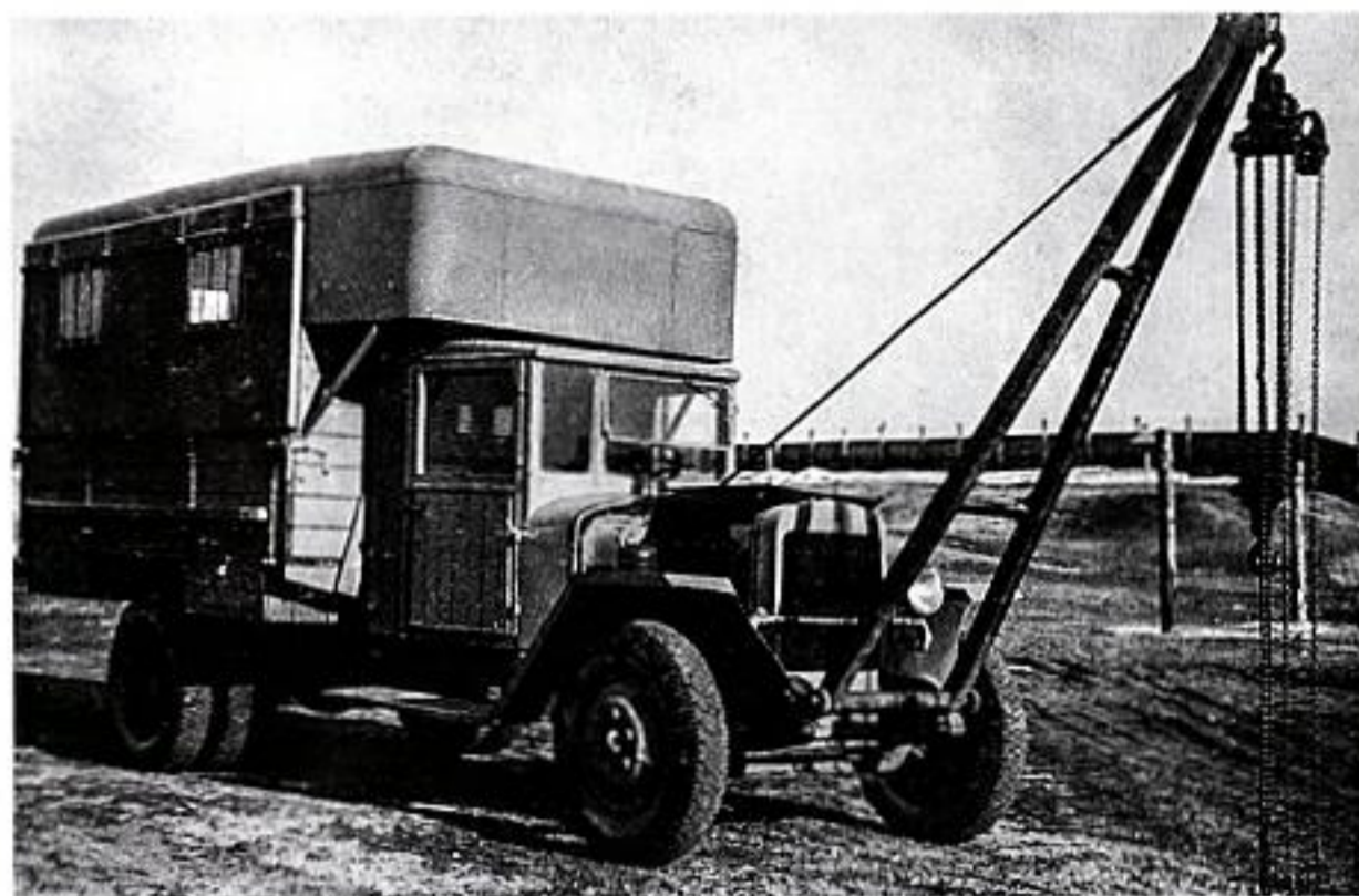
Передвижная ремонтная мастерская на базе грузовика ЗИС-5В
