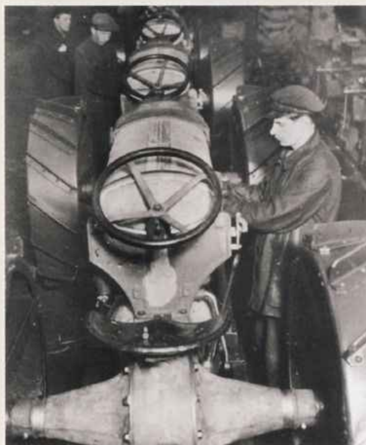
Сборка тракторов на конвейере Кировского завода в довоенные годы.
