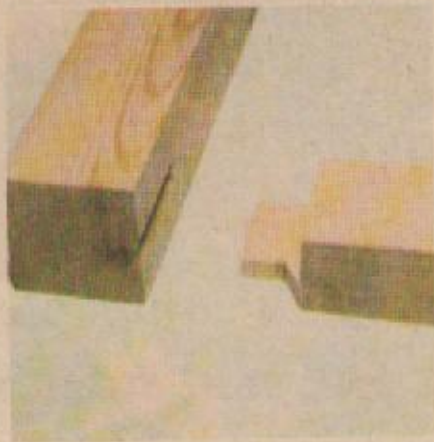
9. Соединение на шип прямой несквозной. Шип сделан со скосом, который усиливает соединение.
