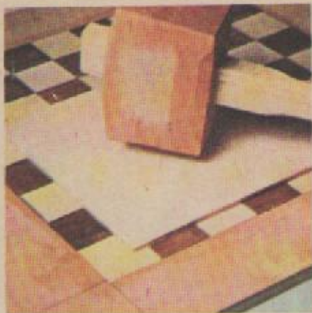
5. Через лист фанеры киянкой или кулаком разгладьте поверхность наклеенного набора.
